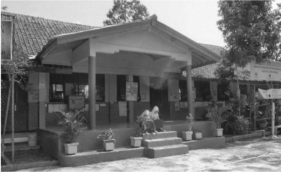
Gambar 1 Gedung sekolah SD Negeri Karangtengah Cianjur. (Sumber: Dokumen Pribadi)
