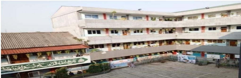
Gambar 3.3 Kondisi Lokasi Bangunan Lembaga
