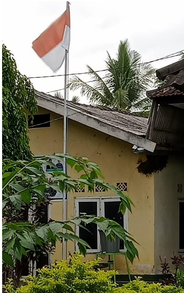
Gambar 17 Aula KUA Kecamatan Keruak
